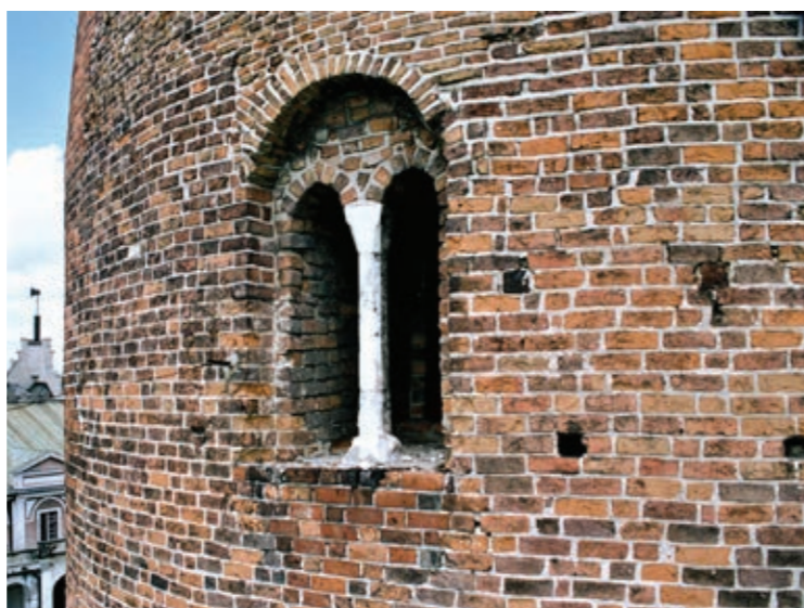
Okno w typie biforium na 3-ciej kondygnacji donżonu.
